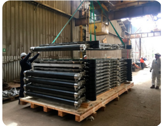
Instalación completa del pack de placas
