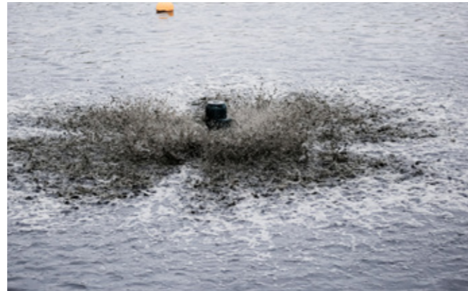
Jäteveden ilmastaminen ei tarvitse monimutkaista infrastruktuuria. Kelluva Roxia-ilmastin on tehokas ja edullinen ratkaisu.
