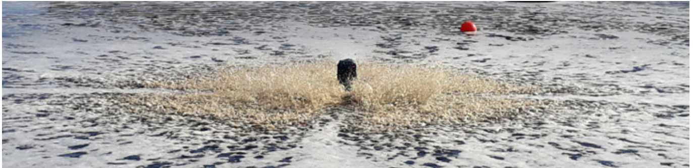
Veden ilmastaminen tasausaltaassa.
