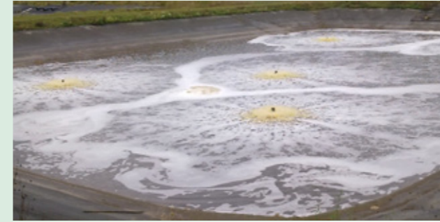
Kaatopaikan suotoveden ilmastaminen.
